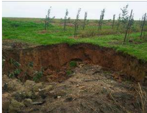
Figuur 64: De bermravijn in de Driewilgenstraat.
