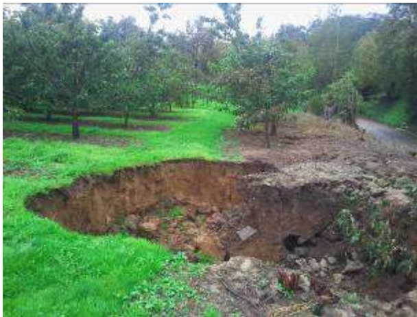
Figuur 63: De bermravijn in de Driewilgenstraat.
