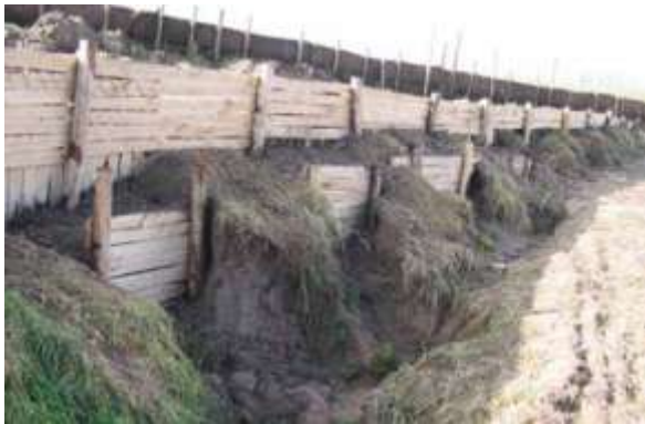
Figuur 14: Het gebruik van palen met planken. (Ministerie van de Vlaamse Gemeenschap, 2002.)
