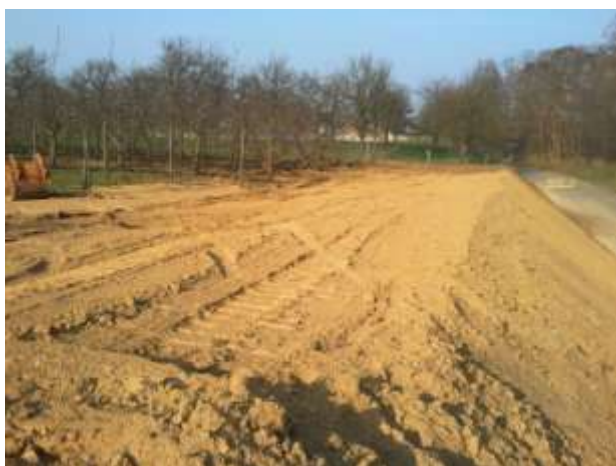
Figuur 66: Herstel van de berm met bermravijnen.
