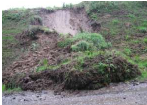
Figuur 6: Een voorbeeld van bermafschuiving. (Rappé V., 2011)
